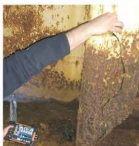
Измерение толщины портового дока
