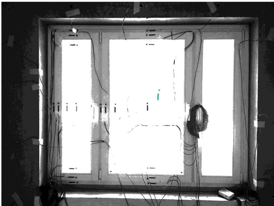
Фото 0.1. Оконный блок по оси 9 в осях Е—И на 3-м этаже 1-й секции с датчиками измерения плотности теплового потока и температуры.
