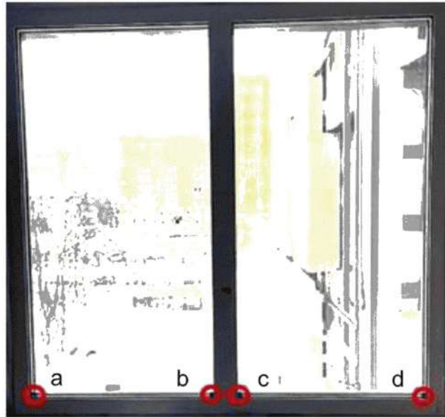
Фото оконного блока с установленным измерительным оборудованием
